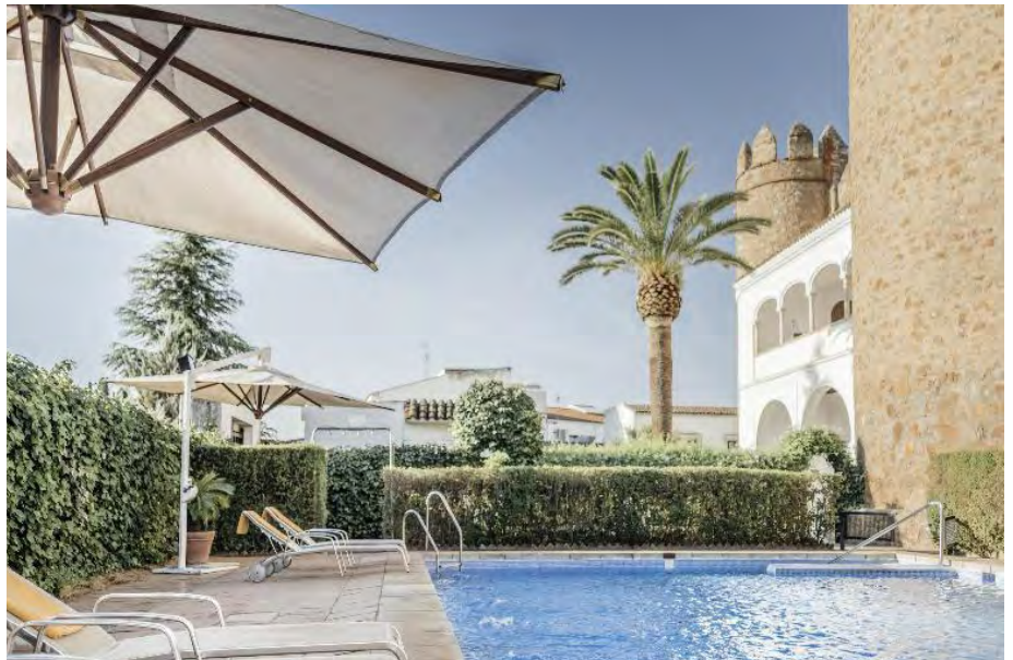
Parador de Zafra: Reforma y adecuación piscina, luminaria exterior y terraza.
